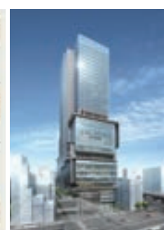
LED照明導入事例：「渋谷ヒカリエ」
