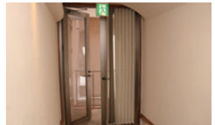
「密閉」を避けるため2～4階廊下のドアもオープン
